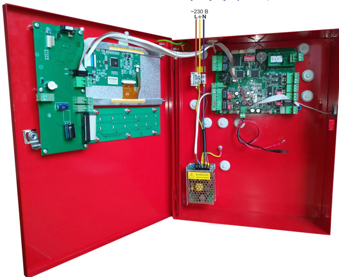
Рисунок 11. Подключение сетевого питания к ППКПиУ «Бирюза-М»
